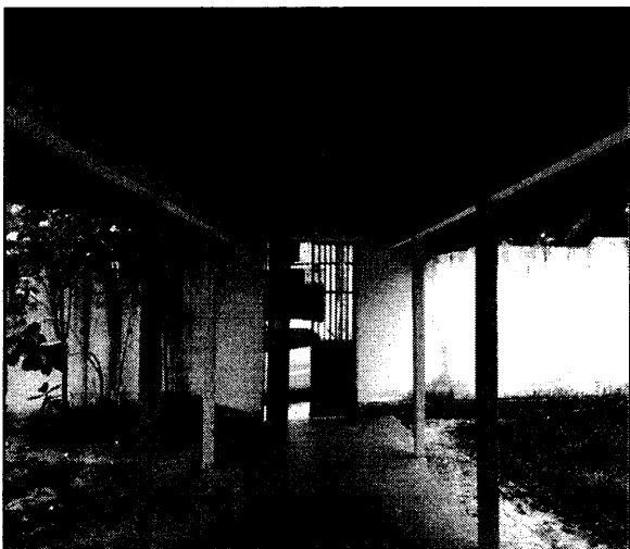
Imagem 03: Passarela coberta que dá acesso a escola.
