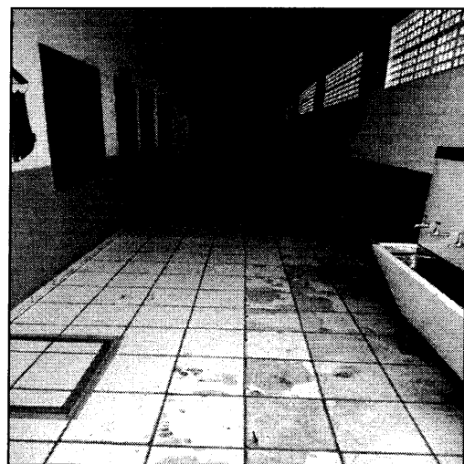
Imagem 04: Circulação da escola. Pintada e com piso cerâmico.
