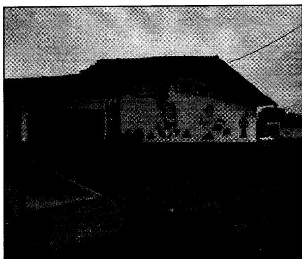
Imagem 01: Fachada da escola.
