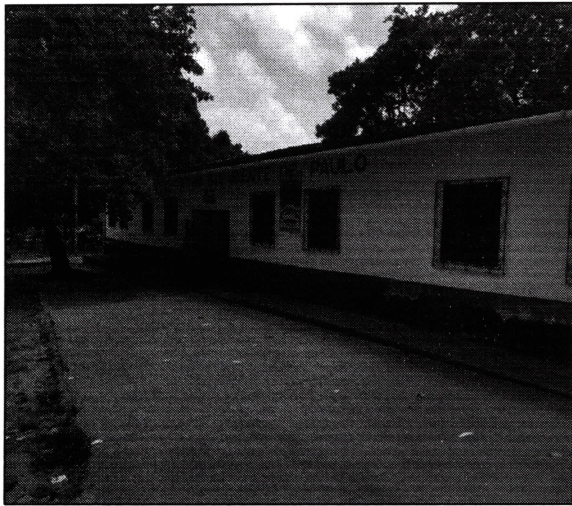
Imagem 01: Fachada da escola.
