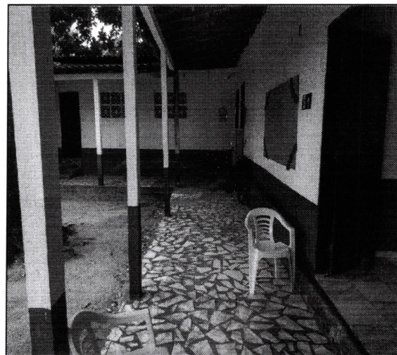
Imagem 04: Área de circulação da escola.
