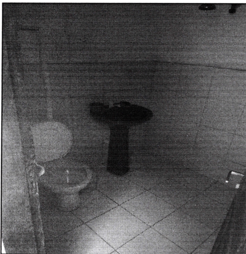
Imagem 11: Banheiro, com piso e revestimento cerâmico.
