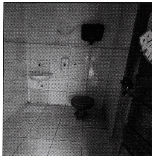
Imagem 12: Banheiro, com piso e revestimento cerâmico.
