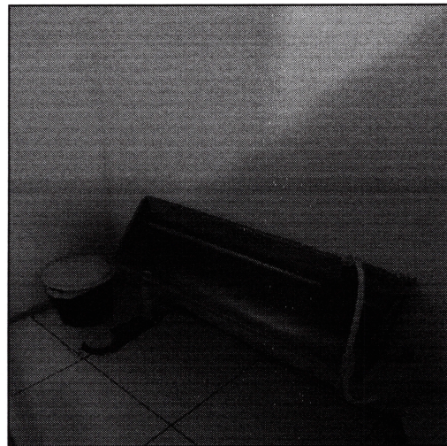
Imagem 12: Banheiro da escola, apenas com piso cerâmico.
