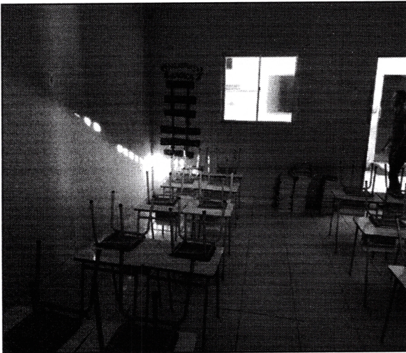
Imagem 05: Sala de aula pintada e com piso cerâmico. Janela de vidro.
