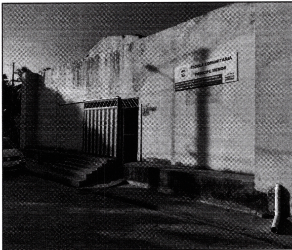
Imagem 01: Fachada da escola.
