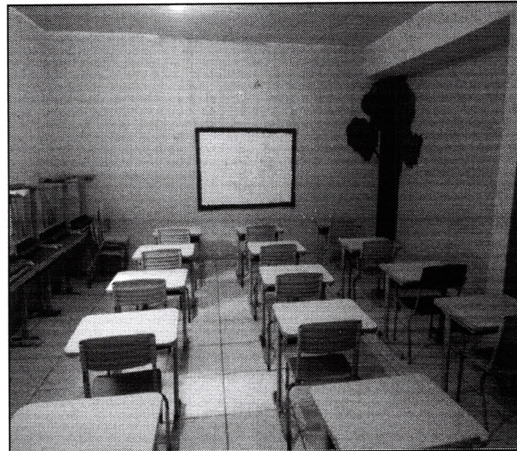
Imagem 06: Sala de aula pintada e com piso cerâmico e forro de PVC.
