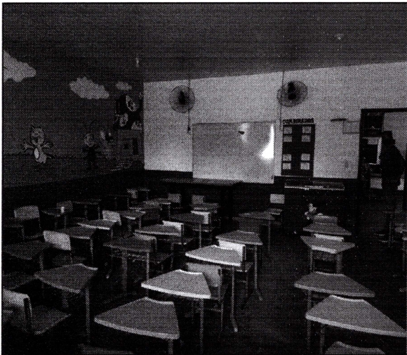
Imagem 05: Sala de aula pintada, com forro de PVC, ventiladores e lâmpadas instaladas.
