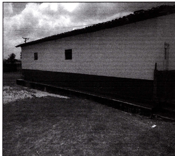
Imagem 02: Fachada da lateral do anexo.
