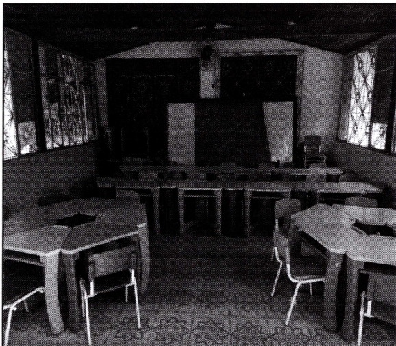
Imagem 03: Sala de aula com piso cerâmico e pintadas. Ventiladores instalados. As janelas são gradis.
