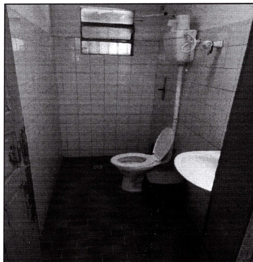
Imagem 10: Banheiro da escola. Piso e revestimento cerâmico.
