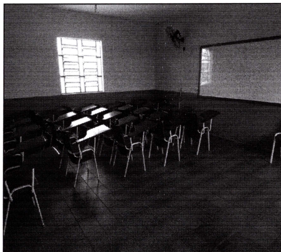
Imagem 08: Sala de aula pintada, com piso e revestimento cerâmico, ventiladores instalados, e forro PVC.
