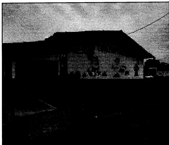
Imagem 01: Fachada da escola.
