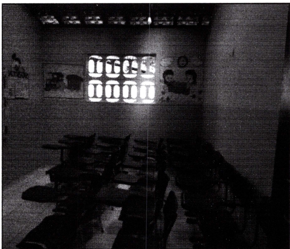
Imagem 07: Sala de aula pintada, com piso cerâmico.
