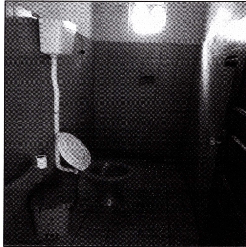
Imagem 10: Banheiro da escola, com piso e revestimento cerâmico.
