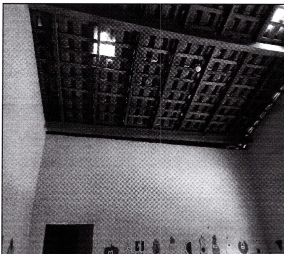
Imagem 11: Estrutura do telhado em madeira, cobertura em telha cerâmica.
