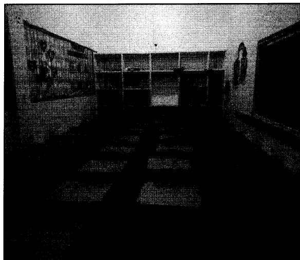
Imagem 08: Sala de aula pintada, com piso cerâmico, janelas de vidro e forro PVC.
