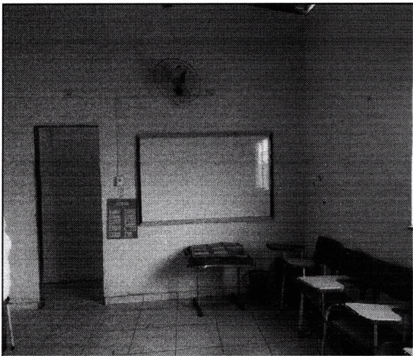
Imagem 07: Sala de aula pintada, com piso cerâmico e forro de PVC. Ventiladores e lâmpadas instaladas.
