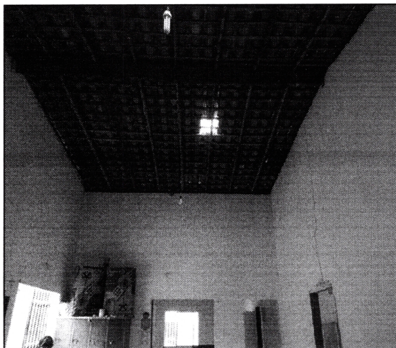
Imagem 11: Cobertura do segundo pavimento. Coberta em estrutura de madeira e telha cerâmica.
