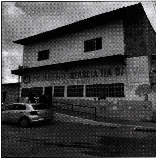
Imagem 01: Fachada da escola.
